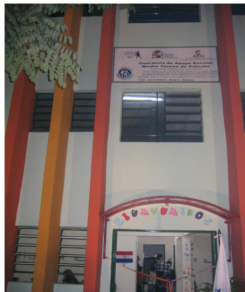
Fachada de la Guardería
