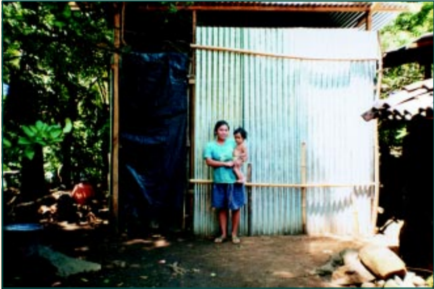
El Salvador, proyecto de reconstrucción de viviendas
